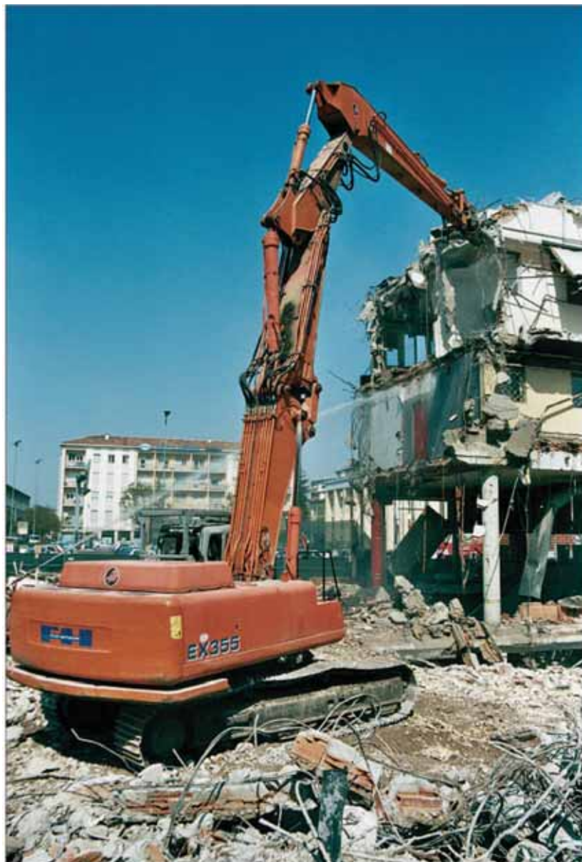
demolizione Ex Standa Pordenone
