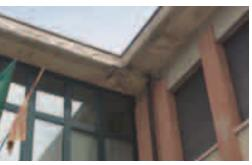
so, come riporta la lettera indirizzata al Comune dall'Usll 20 (protocollata il 2 settembre): "l'edificio presenta, lungo il alto sud di accesso alla scuola e lungo il lato ovest, alcuni punti di sgretolamento dell'intonaco che riveste lo sporto di gronda con rischi di caduta dello stesso al suolo". Dopo aver riportato la dichiarazione dell'ingegnere del Comune secondo il quale "inizieranno a breve i lavori di rifacimento del tetto", la lettera dell'Usll 20 continua:
