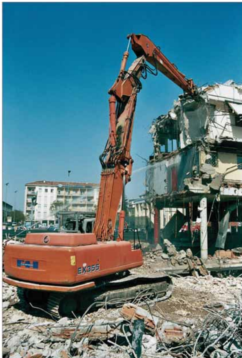
demolizione Ex Standa Pordenone
