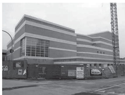
Il cantiere del nuovo teatro
